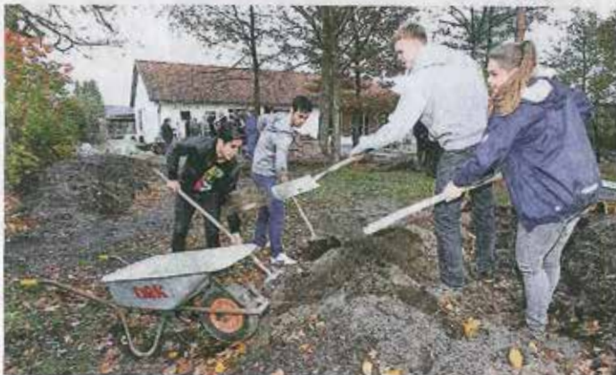
Arbeitseinsatz: 30 Auszubildende der Sparkasse Gifhorn-Wolfsburg halfen gestern bei der Neugestaltung des Außengeländes der DRK-Kita Wagenhoff. Photowork (mpu)
